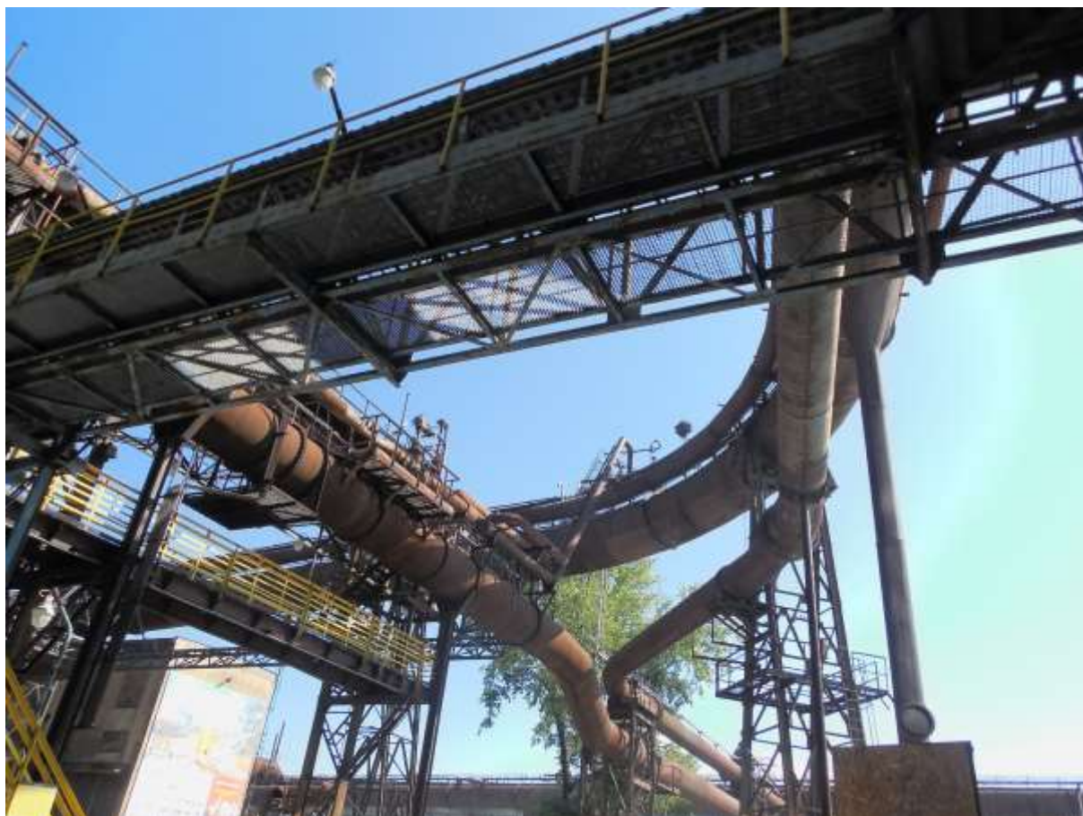
Obrázek 16: Plynová potrubí u 1.vysoké pece
