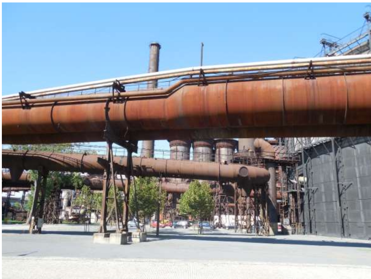
Obrázek 29: Potrubí čistého vysokopecního plynu
