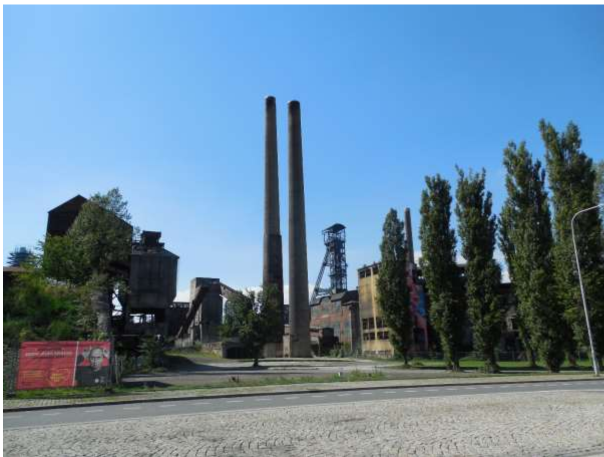
Obrázek 28: Výbuchem poškozený komín koksovny (na obrázku vlevo) s patrným ocelovým zpevňujícím obalem
