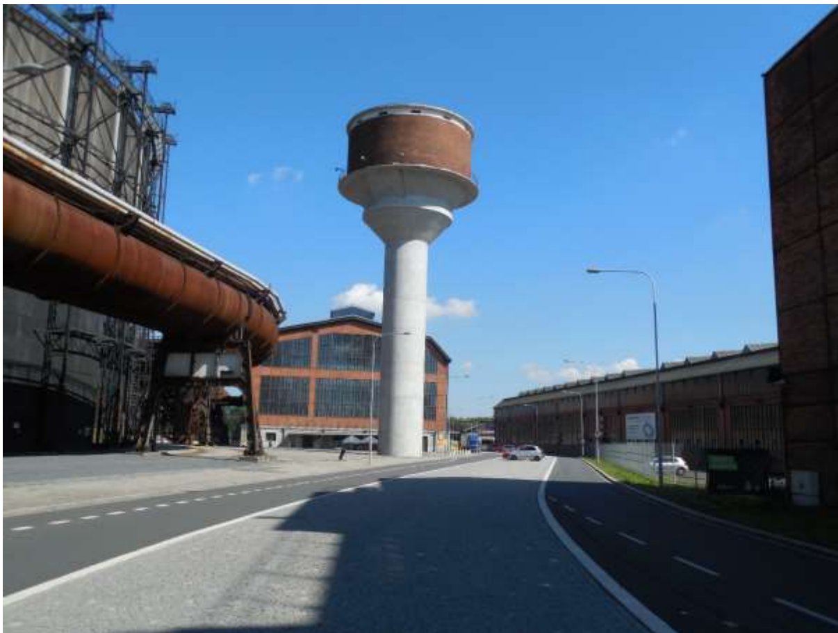
Obrázek 7: Vodojem – bezpečnostní pojistka při výpadku elektrického proudu
