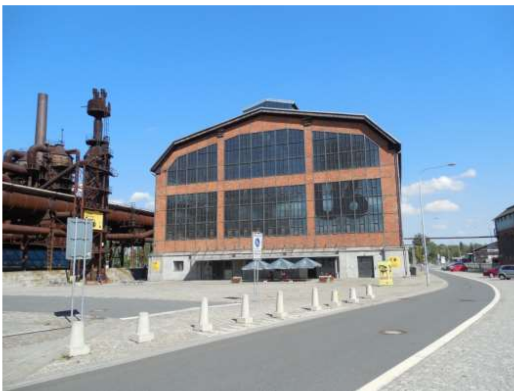
Obrázek 10: Budova 6. ústředny, vlevo svička na spalování přebytečného vysokopecního plynu
