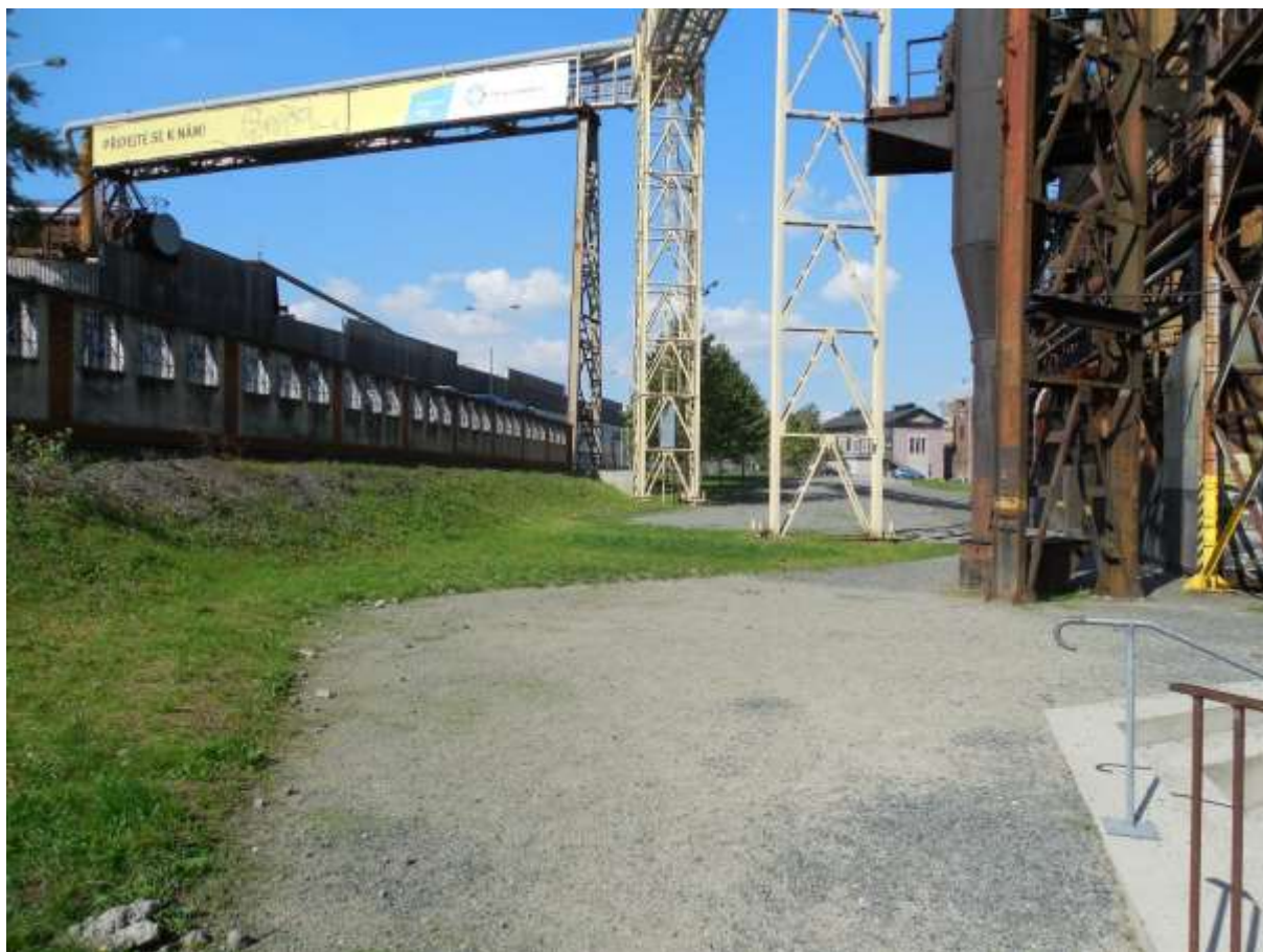
Obrázek 8: Volná plocha po staré čerpací stanici chladících vod u 1. vysoké pece
