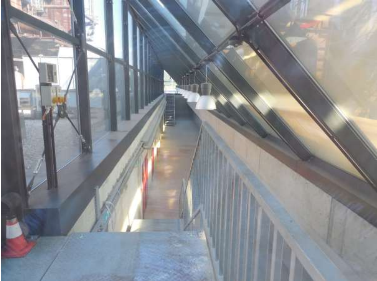
Obrázek 6: Pohled do bývalé čerpací stanice vysokopecních chladících vod
