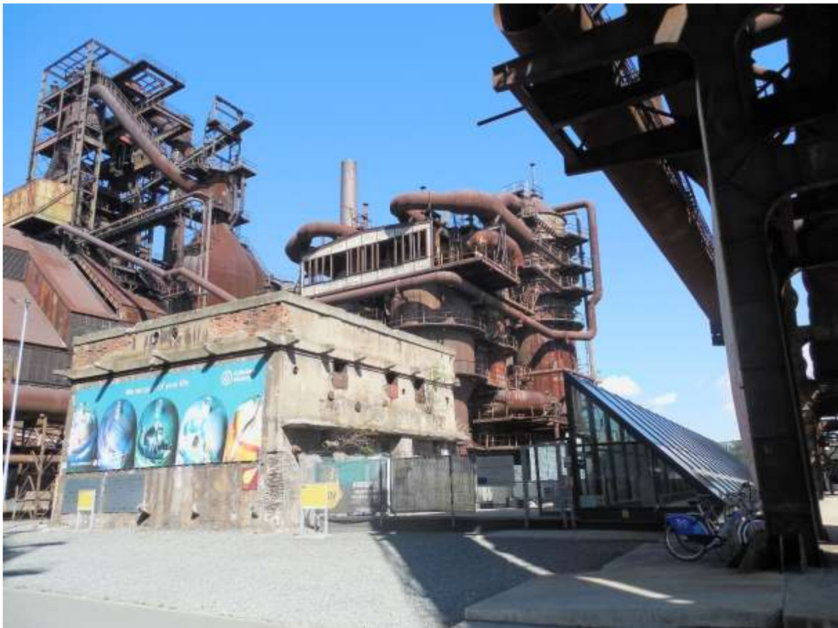
Obrázek 5: Betonový základ chladiče oteplené vody dmychadel 6. ústředny. Vzadu 6. vysoká pec a plynočistírna Lurgi
